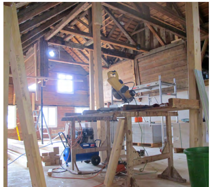
Ausgehöhlt und abgestützt: erste Schritte bei der Renovierung
