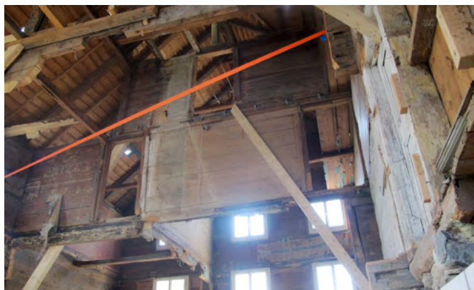
Aufbau der zweigeschossigen oberen Wohnung
